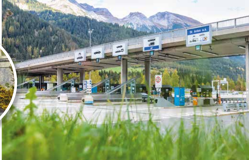
▲ Пункты оплаты на въезде и выезде у Арльбергского автодорожного тоннеля.
